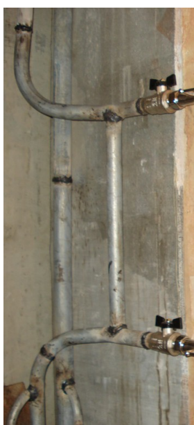
Рисунок 9: Отводы от стояка, смещённый незауженный байпас.
