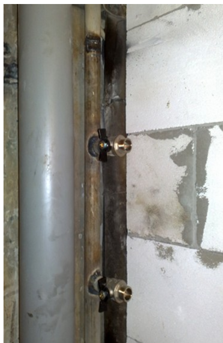
Рисунок 7: Отводы от стояка, несмещённый и незауженный байпас.
