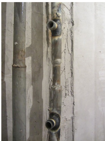
Рисунок 8: Отводы от стояка, зауженный байпас.
