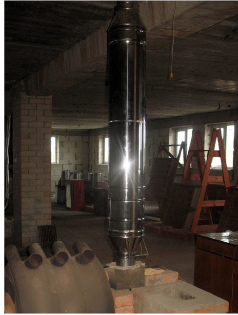
Рис.7. Вид на стенд с трехслойной трубой КДМ
