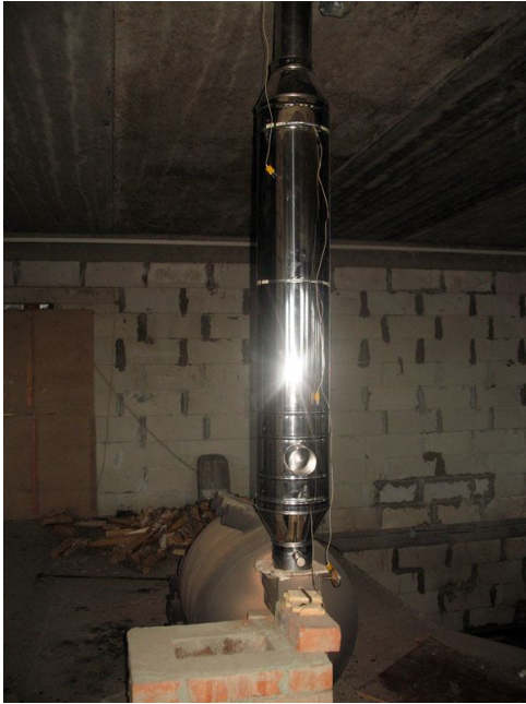
Рис.6. Вид на стенд с трехслойной трубой КДМ
