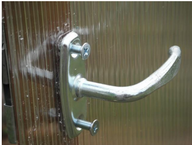
Рис №14 Установка ручки
