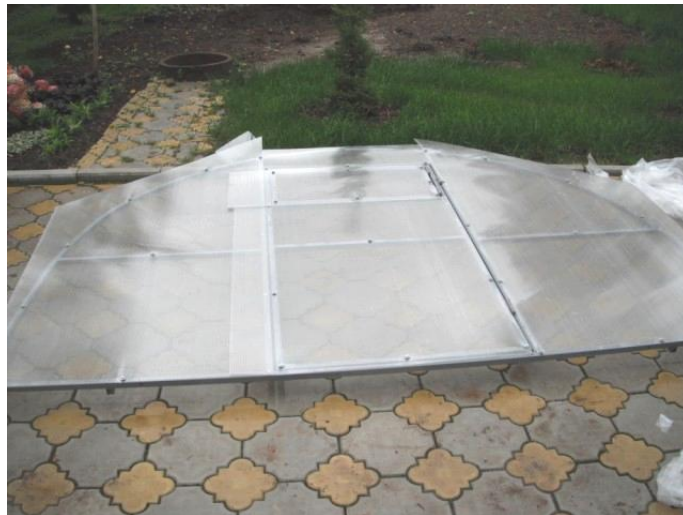
Рис. №3 Схема крепления поликарбоната к торцу.
