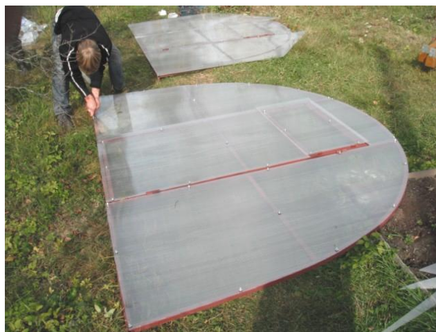
Рис. №4 Подрезка поликарбоната по контуру торца.
