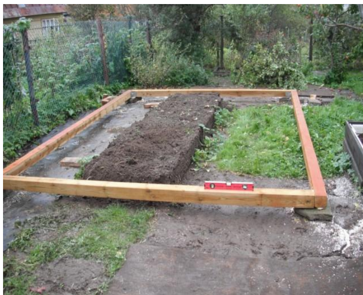
Рис №1. Изготовление деревянного фундамента.
