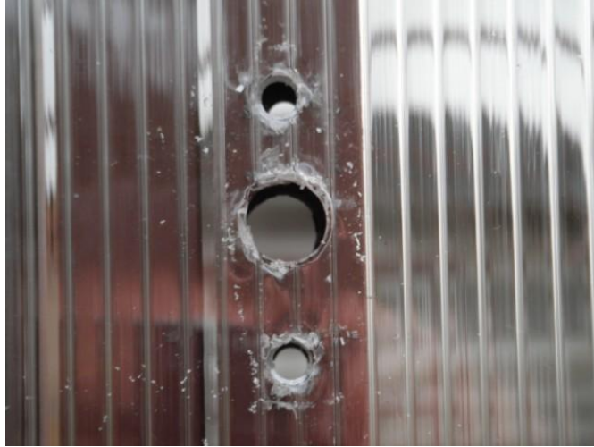
Рис №13 Подготовка отверстий
