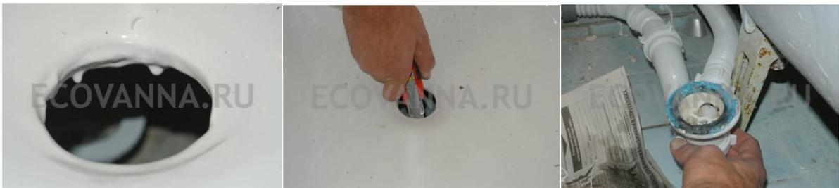
Спустя 36 часов после заливки ванны можно устанавливать обвязку. Обратите внимание на сливное отверстие - обязательно срежьте ножом застывшие капли "сосульки". Перед установкой, обработайте все соединительные части силиконом.
