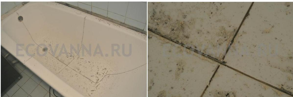
Используя болгарку с отрезным диском, разрежьте поверхность вкладыша, так, чтобы модульно его демонтировать. Перед началом работы оденьте кофту с длинным рукавом, перчатки и защитную маску. Будьте внимательны, не повредите поверхность самой ванны.
