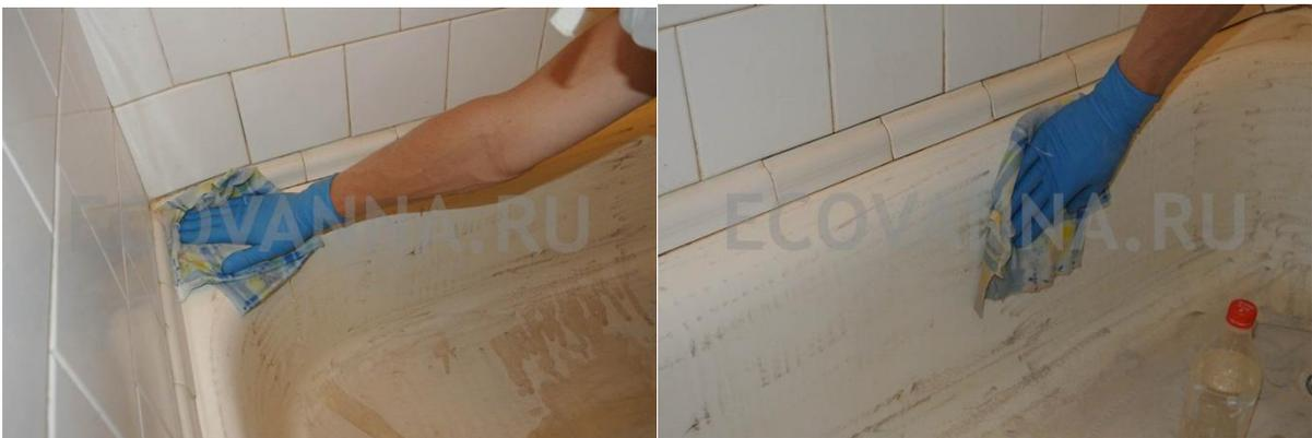
Для обезжиривания поверхности ванны используйте ацетон, нанесенный на тряпку (тряпка не должна ворситься). Повторите процедуру обезжиривания 2-3 раза подряд, разными тряпками.
