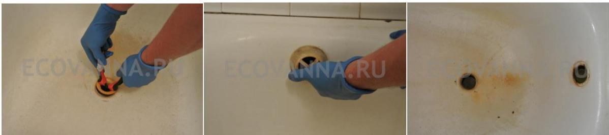
В большинстве случаев, старая обвязка не подлежит обратной установке. Спустя 36 часов устанавливается новая обвязка.
