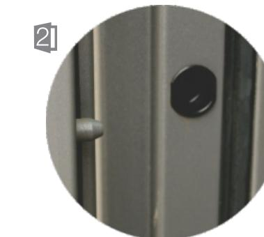
**Терморазрыв как на коробке, так и на полотне не заметен снаружи** так как замаскирован под контурами уплотнителя
