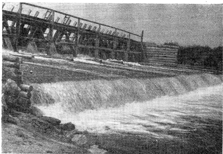
Плотина межколхозной ГЭС.
