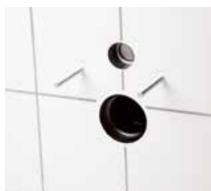
Часть обрезанной заглушки остается в стене, выполняя роль защитной трубы.
