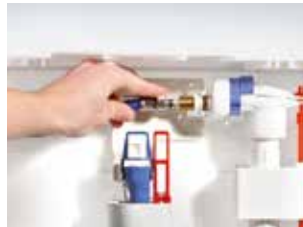
Заливной клапан смонтирован, бачок готов к подключению.
