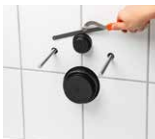
После этого заглушка обрезается ножовкой вровень с поверхностью.
