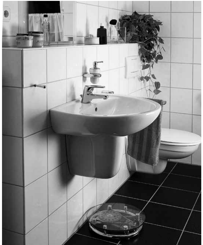
Завершенная перегородка с санфаянсом
