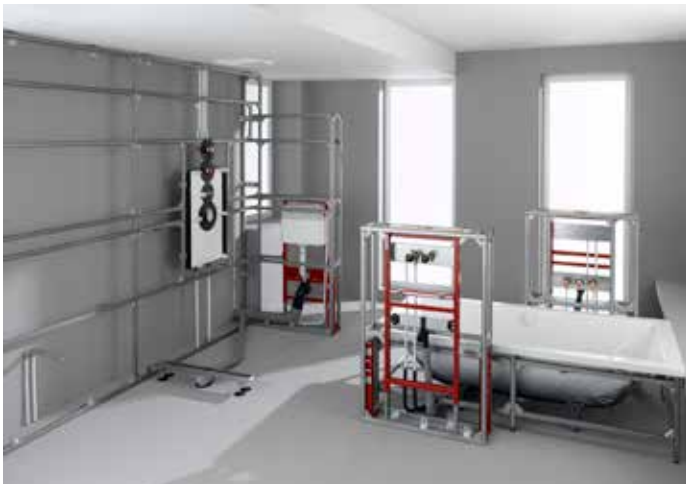
Стены из стального профиля ТЕСЕprofil с сантехническим оборудованием – до облицовки
